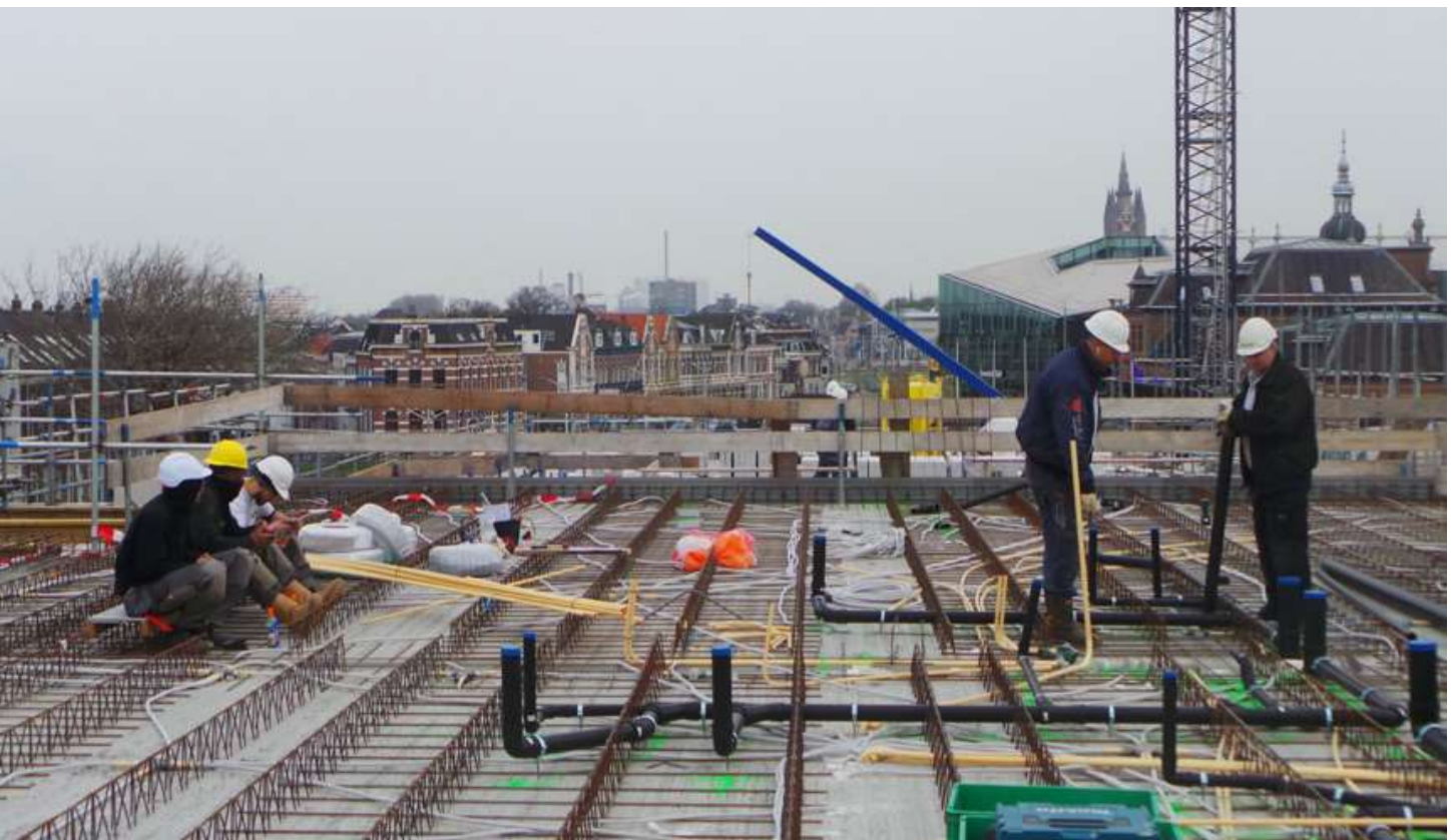
Tweede CPO-project in aanbouw
